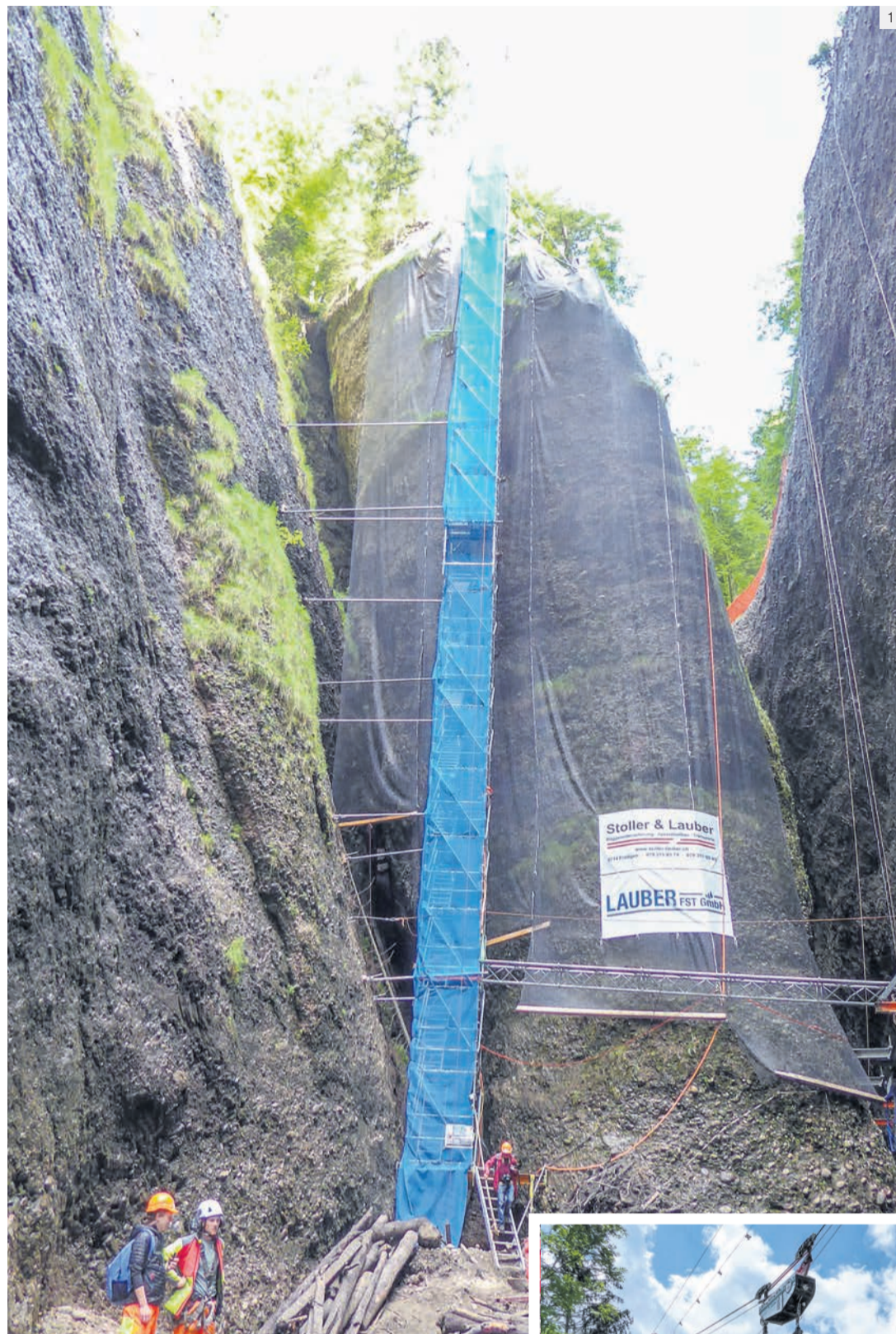
1: Die Treppe im hellblauen Gerüstturm ist Arbeitsweg des Kranführers und Notausstieg zugleich. 2: Die volle Mulde wird zum Umschlagplatz hochge-seilt und dort gekippt. 3: Rudolf Stoller (l.) und Hansjürg Lauber begannen im Herbst mit den Vorarbeiten. 4: Zur Sicherheit mussten erst Steinschlag-netze angebracht werden.
